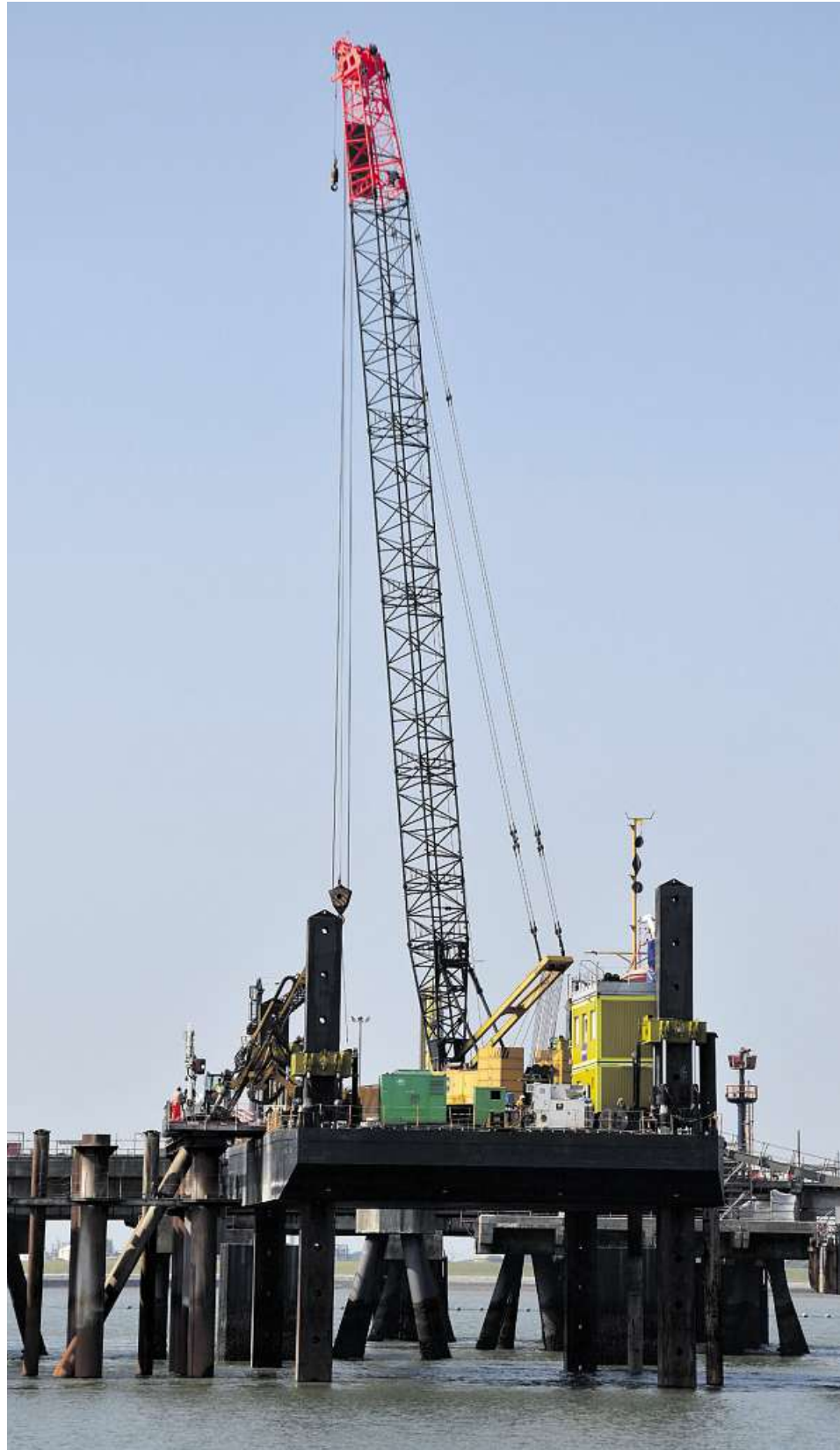
Am neuen Anleger für die Gastanker hat die Hafengesellschaft Niedersachsen-Ports eine Flotte von Hubinseln und Pontons zusammengezogen, um die Arbeiten voranzutreiben. FOTO: BARTH
