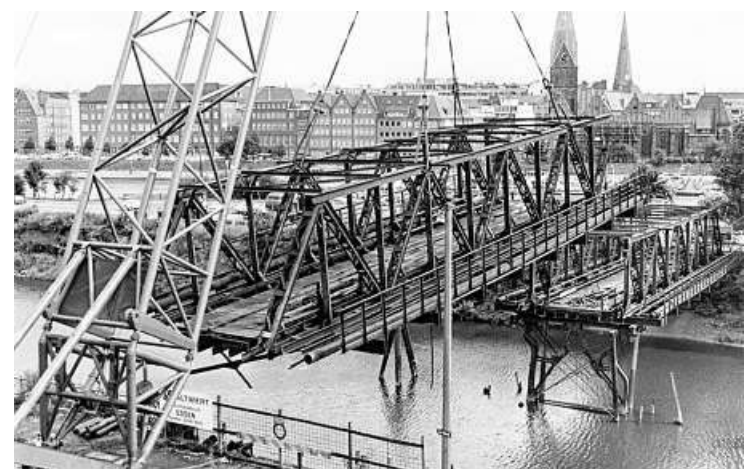
Die altersschwache Brautbrücke wird im August 1972 mithilfe eines Autokrans demontiert.
