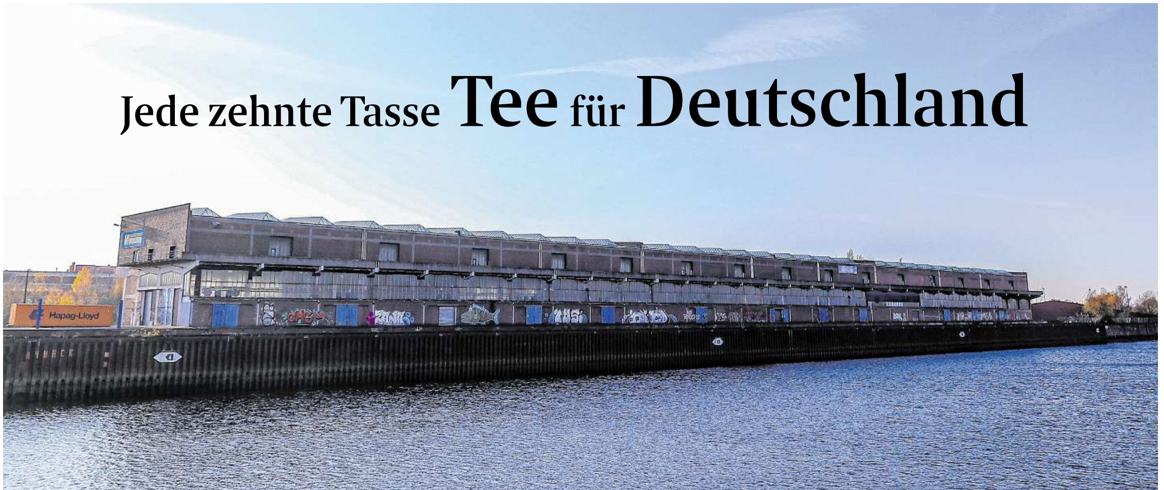
300 Meter lang, 40 Meter breit: Schuppen 6 am Europahafen in der Bremer Überseestadt. Der Gebäuderiegel gehört Vollers, das Grundstück nicht.
