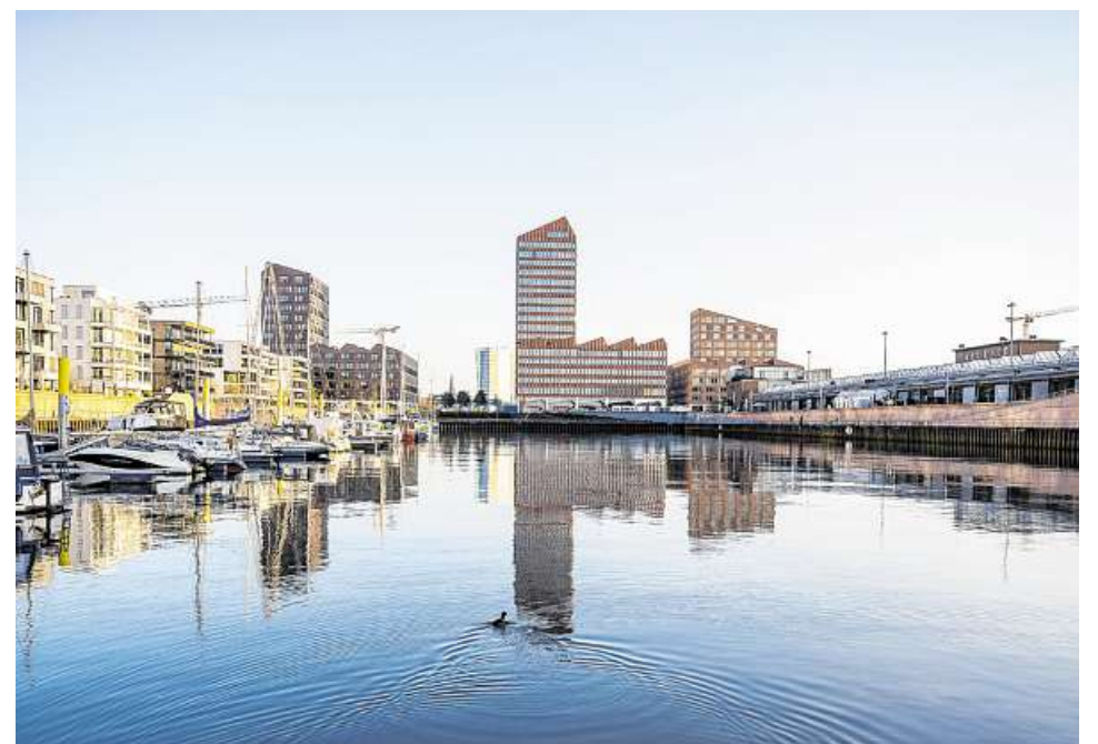
Am Kopf des Europahafens sind vier Gebäude entstanden, darunter in der Mitte des Ensembles die Firmenzentrale der Zech Group.
